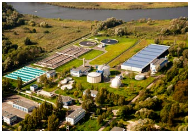
Fot. 105. Oczyszczalnia ścieków Zdroje z lotu ptaka
