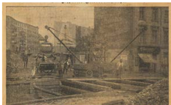
Durch die an der Einmündung Pölitzer- und Friedebornstrasse gebohrt worden. Teile der neuen Kanalisation sind jetzt in Sicht. Die Arbeiten sind sehr eifrig fortgesetzt und durch den im Bild sichtbaren Kran wird die Arbeit sehr erleichtert.
