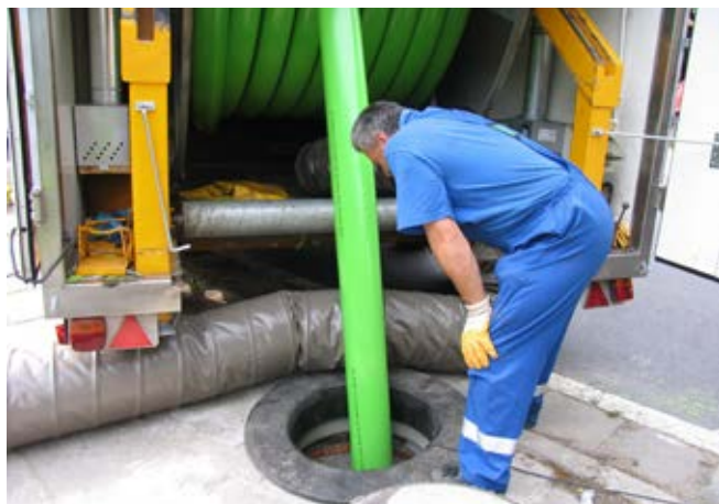
Fot. 106. Renowacja sieci kanalizacyjnej, montaż rury ciasnopasowanej.
