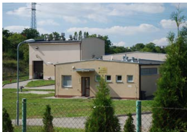
Fot. 92. Pompownia ścieków Białowieska przy ul. Białowieskiej
