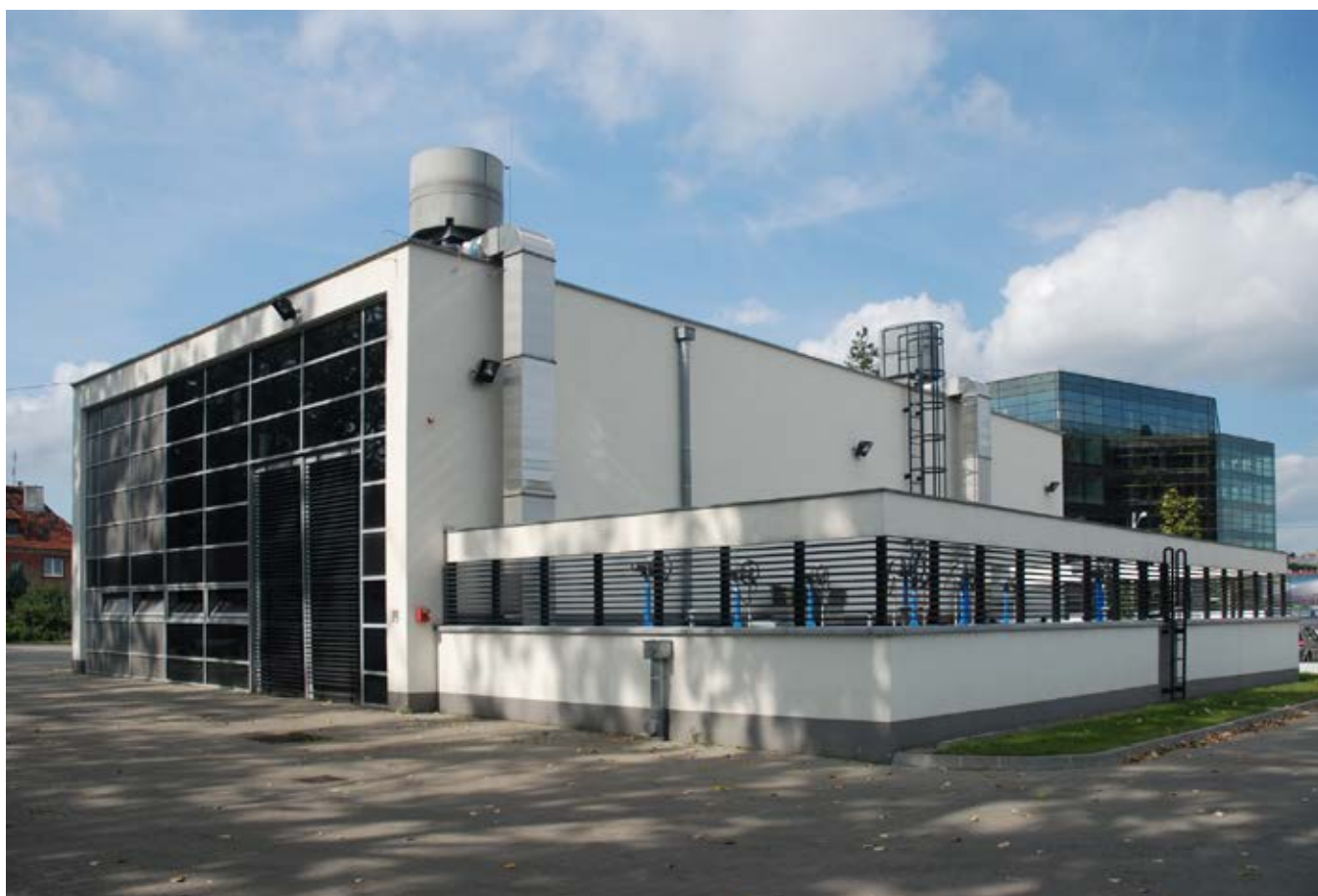
Fot. 109. Pompownia ścieków Grabów przy ul. 1 Maja
