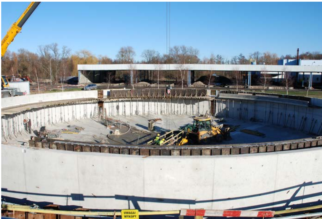
Fot. 112. Rozbudowa Oczyszczalni Ścieków Komunalnych Zdroje
