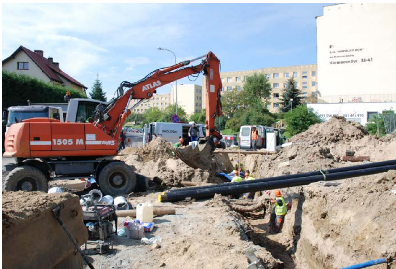
Fot. 116. Budowa kanalizacji sanitarnej w ul. Kormoranów
